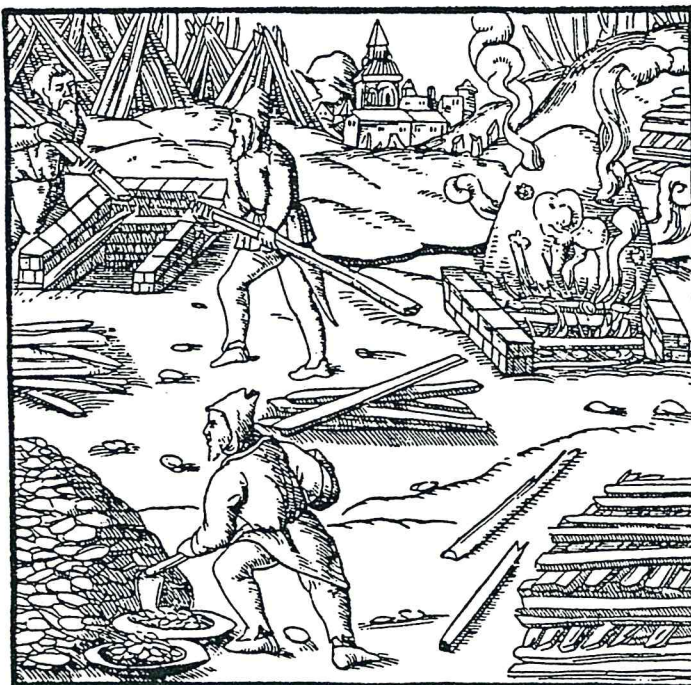
Erzrösterei. Durch das Rösten der Erze wurde das Wasser und die flüchtigen Bestandteile ausgetrieben. Bei den sulfidischen (schwefelhaltigen) Erzen war die Röstung nicht zu umgehen. Das Rösten erfolgte mit einem Holzfeuer, indem man das Erz auf kreuzweise gelegte Langhölzer streute.
